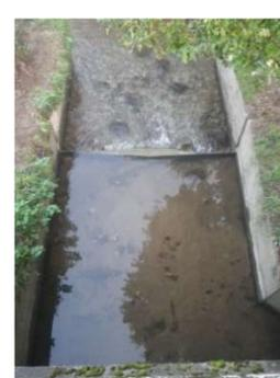
**Photographies de la station hydrométrique du Ris et du déversoir en V**
